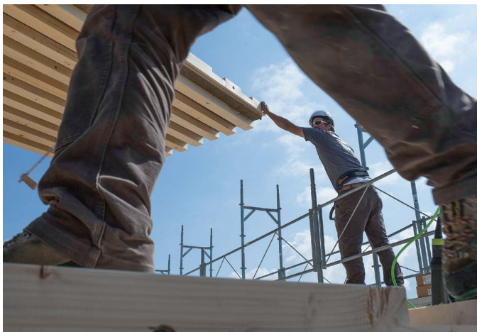
Messa in opera di elementi prefabbricati nell'edilizia in legno. [24]
