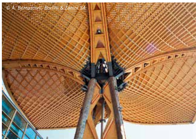
40x40 metri di copertura su stelo centrale formato da legni tondi – Fiera di Hannover 2000
