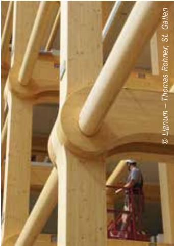
Dettaglio di un nodo della struttura
