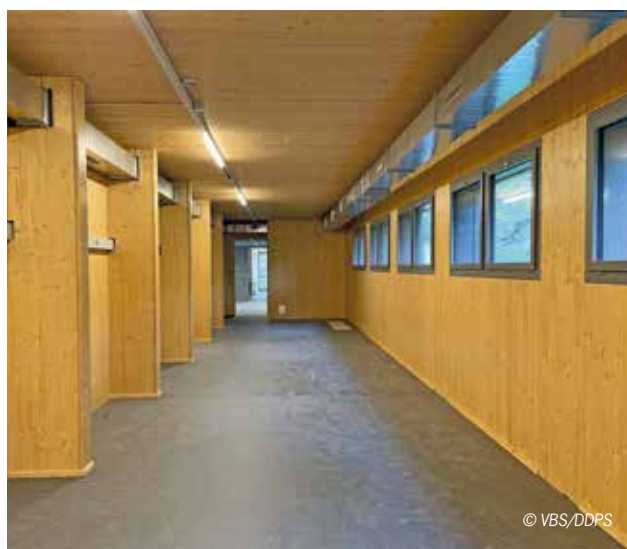
Ampi dormitori per la truppa rivestiti interamente in legno
