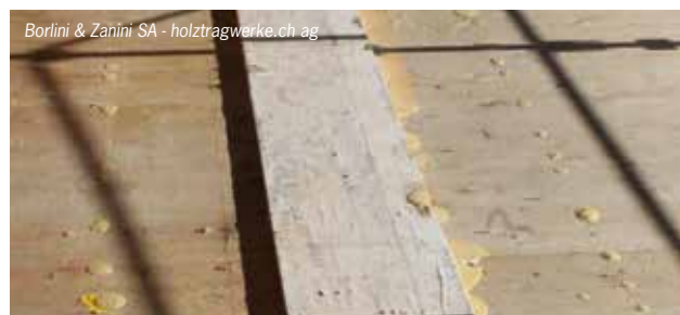
Architrave in spessore nella soletta XLAM sopra alla finestra – vista superiore – ai lati della trave i fori di iniezione con l'adesivo indurito
