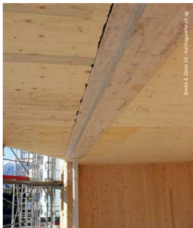
Architrave in spessore nella soletta XLAM sopra alla finestra – vista inferiore – giunto non visibile
