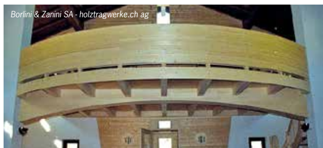
Balconata a sbalzo con struttura in legno con travi ortogonali e complanari
