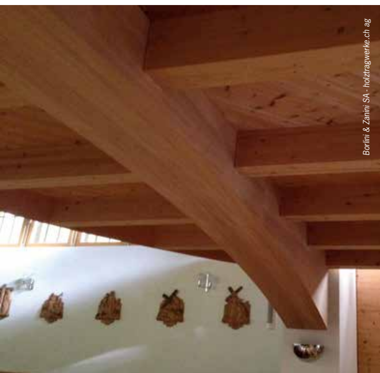
Continuità dei travetti secondari attraverso la trave principale – il giunto non è visibile
