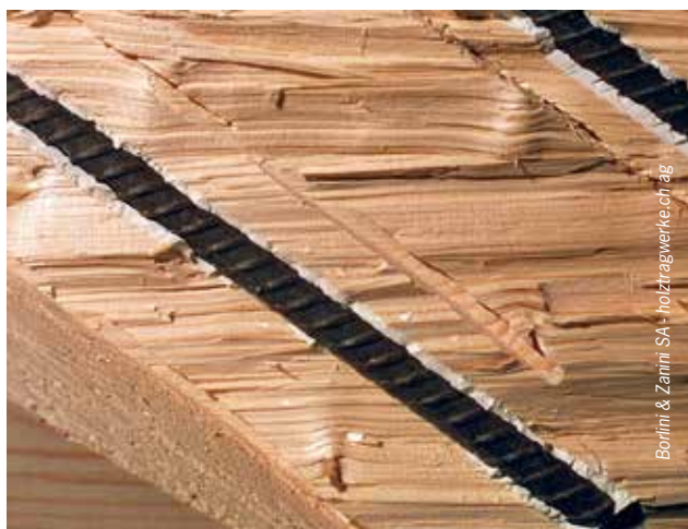
Asta metallica incollata all'interno del legno con adesivo epossidico
